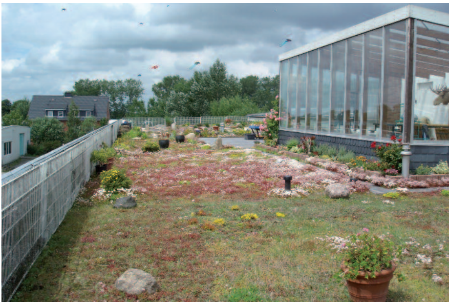
Die intensive Dachbegrünung auf den Neubauten des Gewerbehofes 33 in Kiel prämierte die Jury des Gründachwettbewerbs Schleswig-Holstein/ Metropolregion Hamburg mit dem zweiten Platz. Von den Mietern der Gewerbeflächen wird die 650 Quadratmeter große Dachterrasse unter anderem für Kundenveranstaltungen genutzt.
