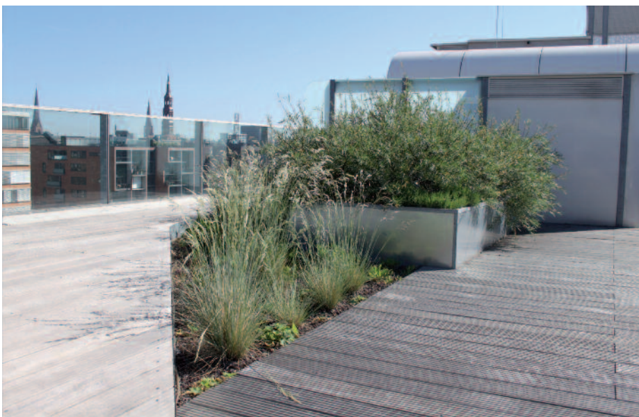
Dass eine professionelle Dachbegrünung auch nachträglich realisiert werden kann, beweist die Dachterrasse dieses Wohnhauses in der Hafen-City. Die Gebäudeeigentümer hatten sich erst für eine Dachbegrünung entschieden, nachdem die Planung der Statik und der Dachkonstruktion bereits abgeschlossen war.
